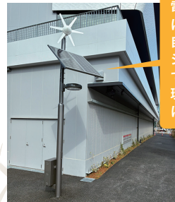
《ハイブリッド型街路灯》 風力+太陽光によるクリーンな照明
